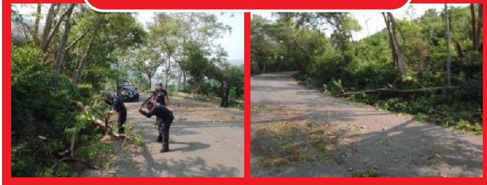
Eje carretero san Antonio-Puente
