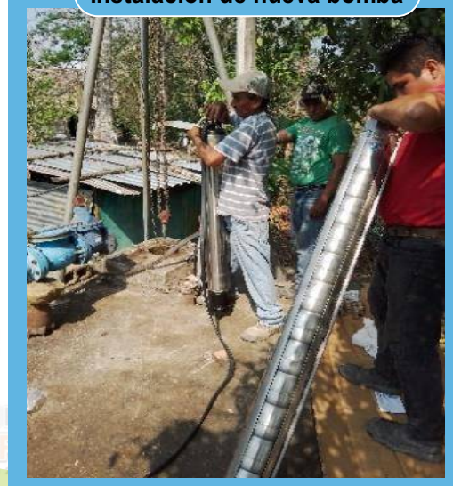
Instalación de nueva bomba
