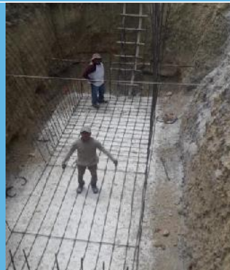
Avances obra Tanjasnec, cárcamo de bombeo.
