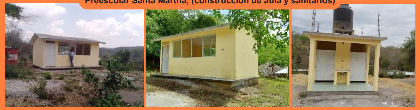
Preescolar Santa Martha, (construcción de aula y sanitarios)
